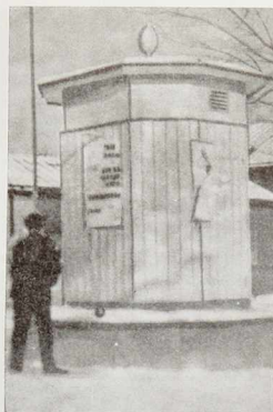
Pumpukavaio Kupittaankadun ja Kaskenkadun kulmassa
