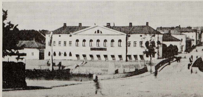
Societetshuset (nuv. Stadsbuset) byggdes åren 1811—12, under tiden för branden år 1827 och tjänade som residens för våra resenärer.
