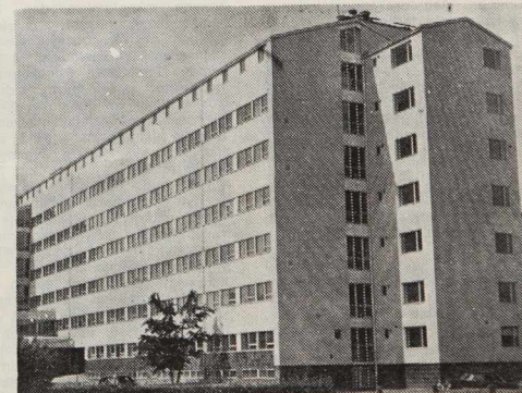
● Turun Yliopiston lääketieteellisen laitosrakennus.
