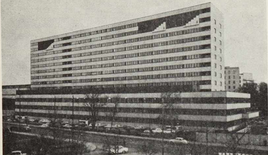
● Turun yliopistollisen keskussairaalan rakentamiskysymyksiin samoin kuin sairaalan nykyisen ylläpitöjärjestelmän kunnille aiheuttamien kustannuksiin Maakuntaliitto on puuttunut viime vuosien aikana useasti.
